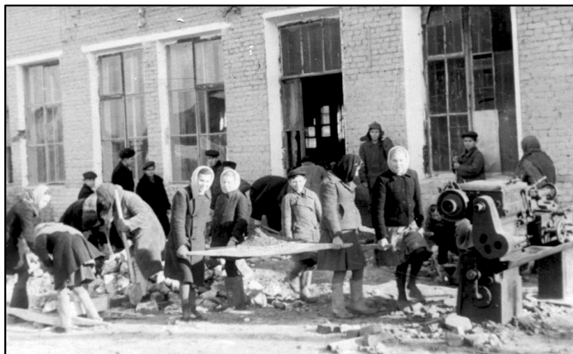
Строительство нового корпуса на территории завода № 2 Народного комиссариата вооружения. 1941 г.
